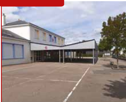
École Élémentaire – Extension du Préau — Coût de l'opération : 30 954 € HT
