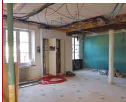
Mairie - Réaménagement — Coût de l'opération : 178 008 € HT
