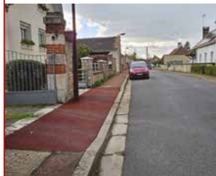
Rue Fleurie – rénovation partielle des trottoirs — Coût de l'opération : 20 647 € HT
