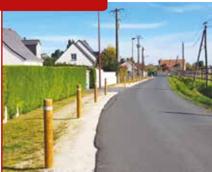
Route de Mazières - Sécurisation — Coût de l'opération : 1 809 € HT
