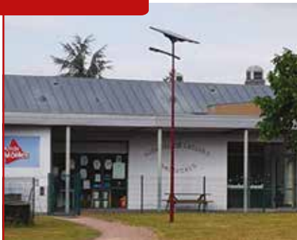
Luminaire Led – Toute la commune — Coût de l'opération : 21 951€ HT
