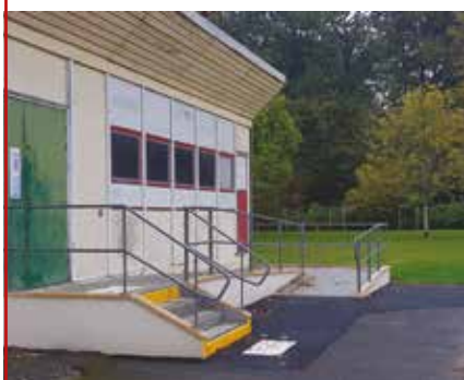
Accessibilité bâtiment stade — Coût de l'opération : 21 780 € HT
