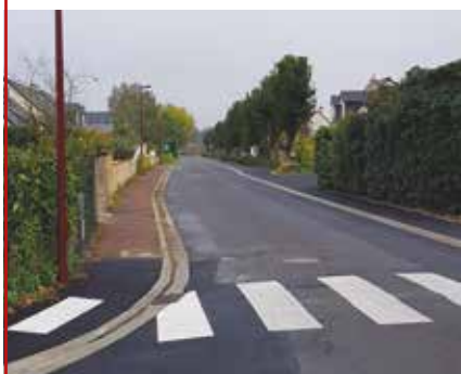
Chemin des Épinettes – Enfouissement des réseaux — Coût de l'opération : 114 577 €
