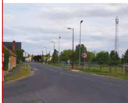
Route de Courcelles – Enfouissement des réseaux — Coût de l'opération : 108 121 € HT
