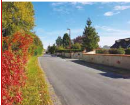
Chemin de la Vacance – Enfouissement des réseaux — Coût de l'opération : 56 932 €
